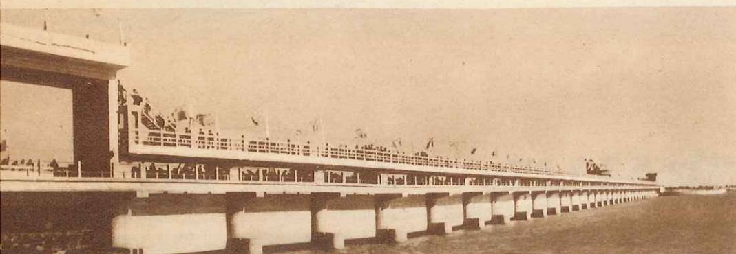
Ein Damm in China wird aufgebaut. In seinem ständigen Kampf gegen die Überschwemmungen der großen Ströme hat die chinesische Regierung den Bau von Dämmen und die Anlegung von Stauseen zur Regulierung der Wasserführung in letzter Zeit forciert. Vor kurzem ist mit einer Länge von 558 Metern und mit der Höhe von 88,50 Metern der Huai-Damm fertiggestellt worden, der die Überschwemmungen des Huai-Flusses verhindern soll. Der entstandene Damm wird zwei Milliarden Kubikmeter Wasser fassen. Eine Kulturfläche von rund 930 000 Hektaren wird künftig vor Überschwemmungen geschützt sein.
